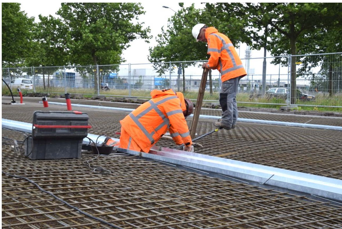
Foto: Aanleg wapening voorziening.
